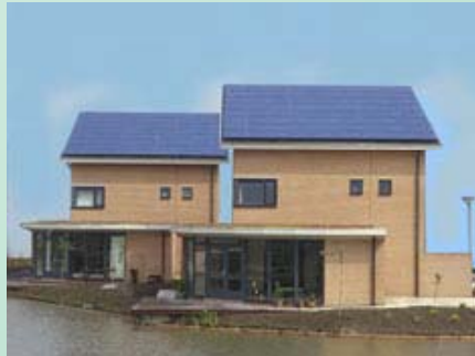
Maisons à Langedijk
