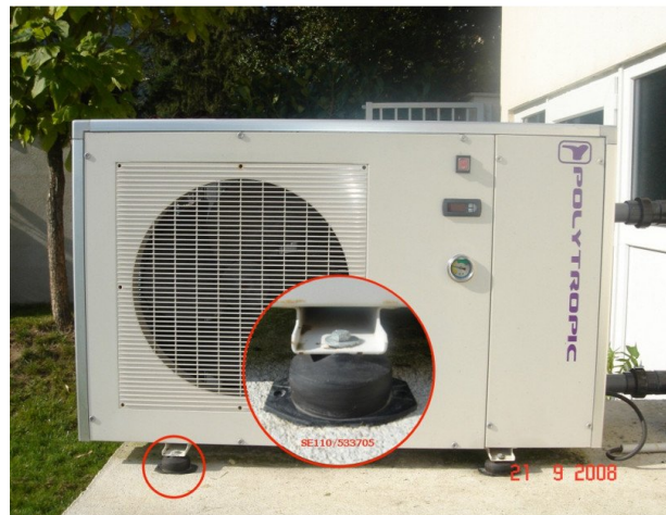
FIGURE 9.15 – Climatiseur monté sur plot.
