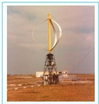
Figure 13 – Prototype français tripaile de machine Darrieus 6 MW (source : Centre National d'Essais d'Éolienne de Lannion, 1985, crédit : Onera)
