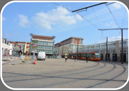
Aménagement d'un pôle d'échange multimodal Le Mans, 2015
