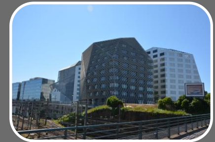
Création d'immeubles de bureaux Rennes, 2021
