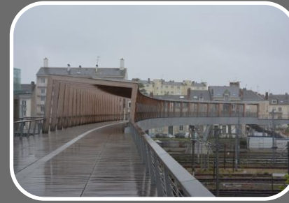
Ouvrages de franchissement des voies Angers, 2021
