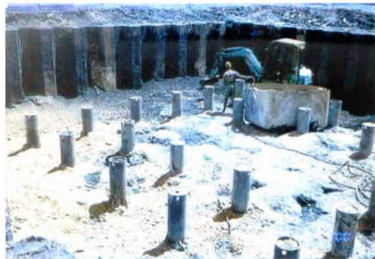
Photo 5 Massif de jet grouting en cours de recépage avec ses minipieux
