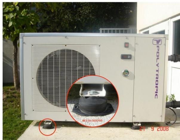
FIGURE 9.15 – Climatiseur monté sur plot.
