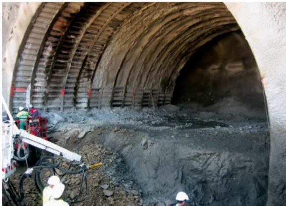
Figure 1.2. Tunnel 186 – Creusement traditionnel en demi-section
