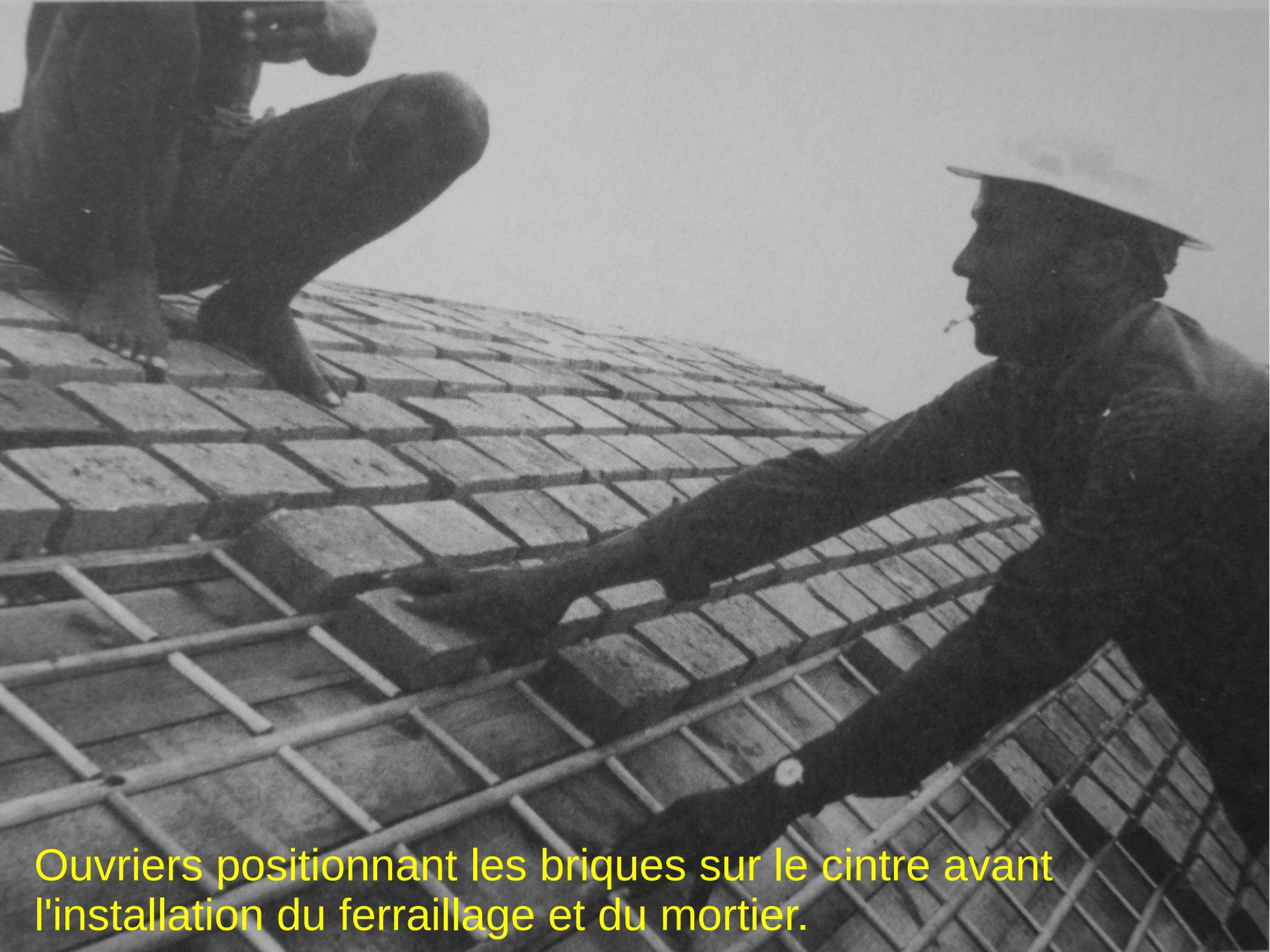
Ouvriers positionnant les briques sur le cintre avant l'installation du ferrailage et du mortier.
