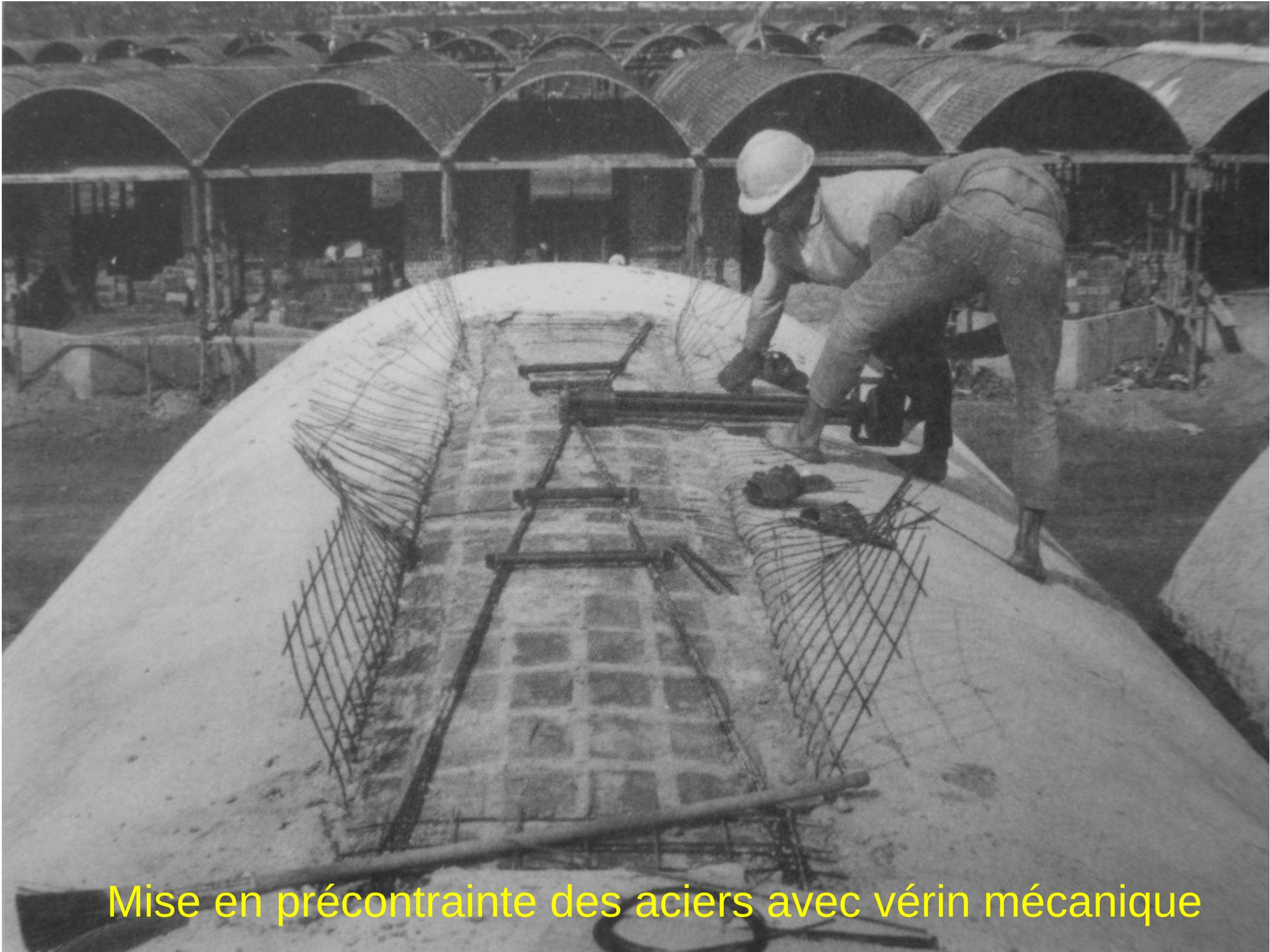
Mise en précontrainte des aciers avec vérin mécanique
