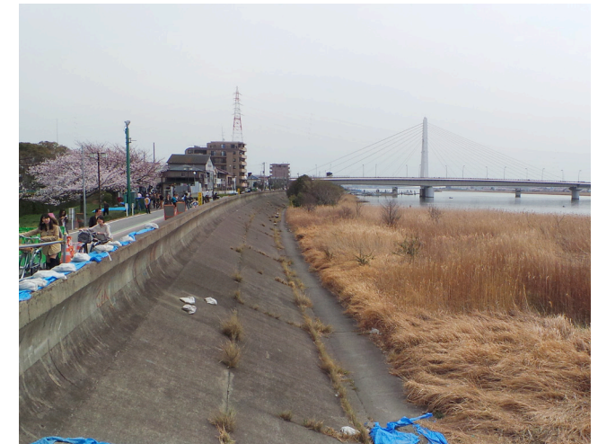
Absence d'aménagement des berges et des digues
