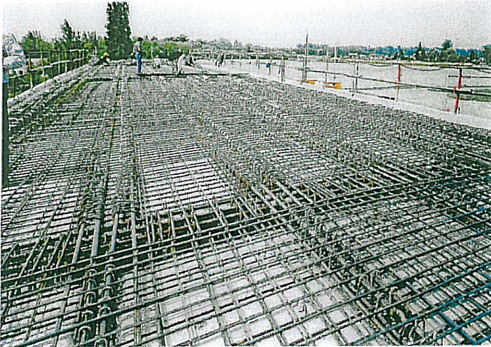
Ferraillage du tablier - Vue générale.
